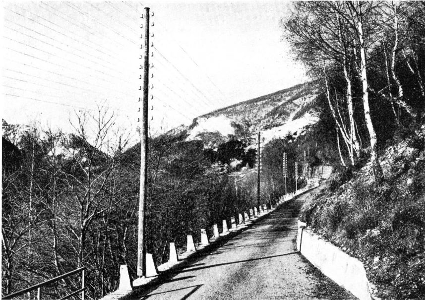
Fig. 3 Linee aeree dopo Crana (veranno demolite)
