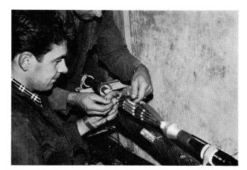
Fig. 30 Kleinkoaxialkabel-Spleissergruppe an der Arbeit
