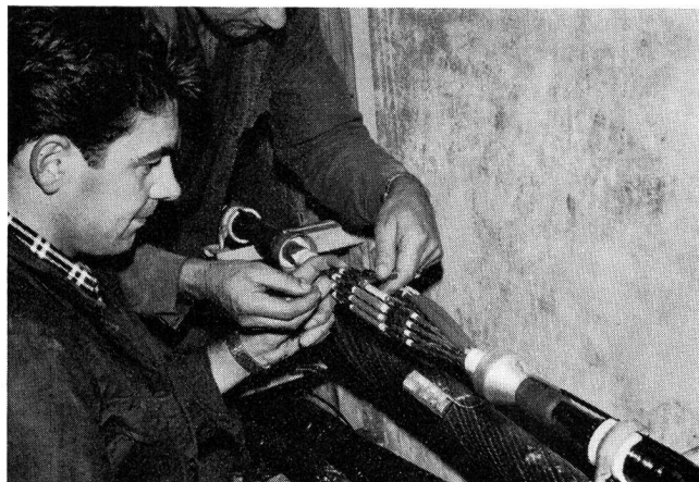
Fig. 30 Kleinkoaxialkabel-Spleissergruppe an der Arbeit
