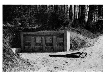
Fig. 24 Schachtaufbau bei zwei Verstärkern im gleichen Schacht
