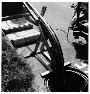
Fig. 23 Kabeleinlauf in Einstiegschacht über ein Rollensegment
