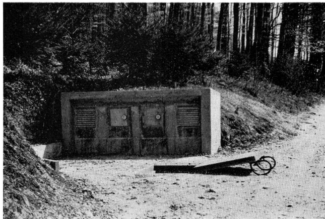
Fig. 24 Schachtaufbau bei zwei Verstärkern im gleichen Schacht
