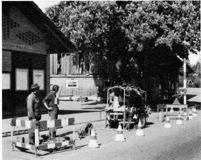
Fig. 22 Einzugwinde mit Benzinmotorantrieb
