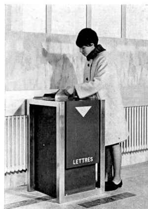
Fig. 3 Hall de l'office de dépôt. Boîte aux lettres avec levée automatique, la correspondance étant transportée par ruban au tri des lettres
