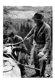
Fig. 3 Montagearbeiten am Übergang von Erdkabel zu Luftkabel (Photos E. Coèndet)
