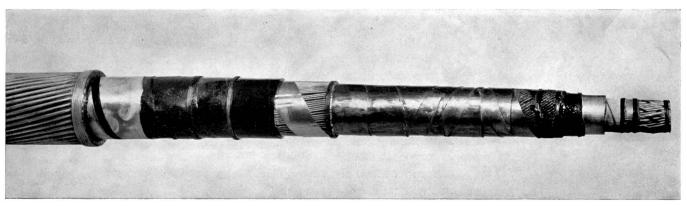
Bleimäntel werden gegen Ermüdungserscheinungen mit 0,7% Antimon legiert. Um den Mantel wird ein den Verhältnissen angepasster Korrosionsschutz aufgetragen. Dieser kann aus Kunststoffolien und teergetränkter Jute oder einer PVC-Hülle aufgebaut sein. Eine Eisenbandarmatur empfiehlt sich als Stütze des Bleimantels, um die Festigkeit im Querschnitt zu erhalten. Darüber wird die Tragarmatur aus verzinkten hochwertigen Stahldrähten angebracht.
