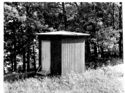
Fig. 10 Eines der Häuschen, wie sie in Schweden zahlreich für die automatischen Landzentralen mit höchstens 60 Anschlüssen verwendet werden
