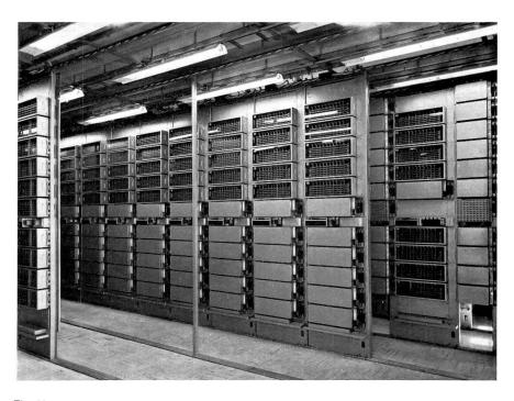
Fig.11 Kreuzwählerzentrale des Systems A-204 für grössere Ämter
