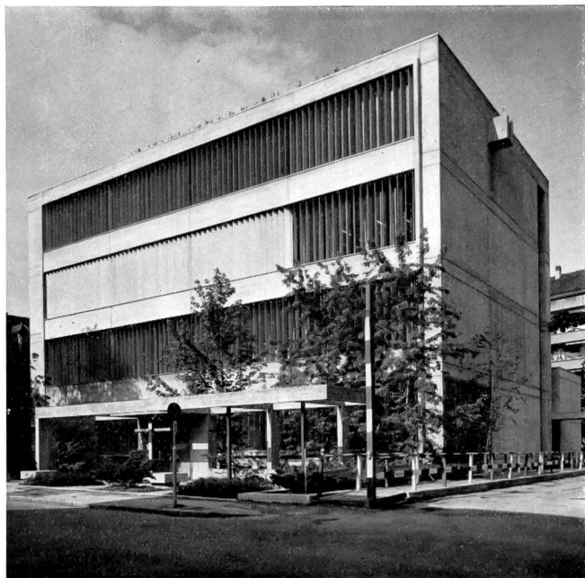
Fig. 1 Gebäude der Zentrale Mattenhof Bâtiment du central du Mattenhof
