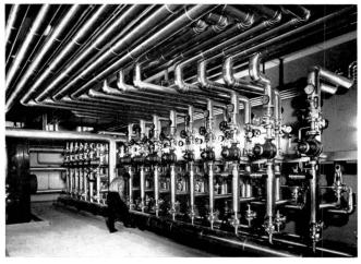
Fig. 3 Heizverteiler mit 16 vollautomatisch regulierenden Heizgruppen
