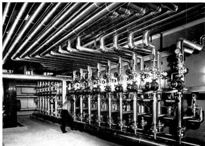
Fig. 3 Heizverteiler mit 16 vollautomatisch regulierenden Heizgruppen
