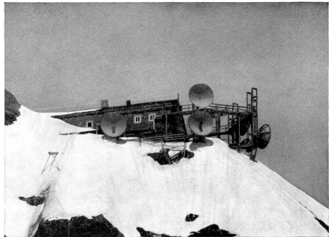
Fig. 2 Ansicht der Richtstrahlstation von Südosten
