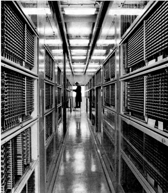
Pentacontaschalter-Rahmen für die automatische Anrufverteilung
