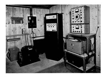
Fig. 2 Vibrationsanlage Derritron mit Steuerung Brüel & Kjaer. Von links nach rechts: Autotrafo für Netzsimulatorbetrieb, darüber Schiebewiderstand für die Feldkompensation (degaussing); Vibrator VP75 mit Kristall-Pick-ups, darüber Vorverstärker 2620; Verstärker 2,5 KWLF mit Ausgangstrafo dahinter; im Gestell: unten Felderregergerät, Schreiber Oscilloscript, Vibrationsmeter 2501, Steuergenerator 1040.
