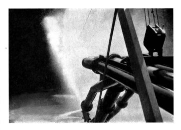
${\it Fig.~2} \\ {\it Der~Saugarm~ist~hochgezogen,~die~Wasserstrahldüsen~sind~noch~in} \\ {\it Funktion}$
