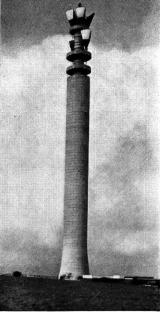
Fig. 3 und 4 Stahlgittermast und Beton-Fernmeldeturm (Birmingham) des General Post Office für Richtstrahlstrecken
