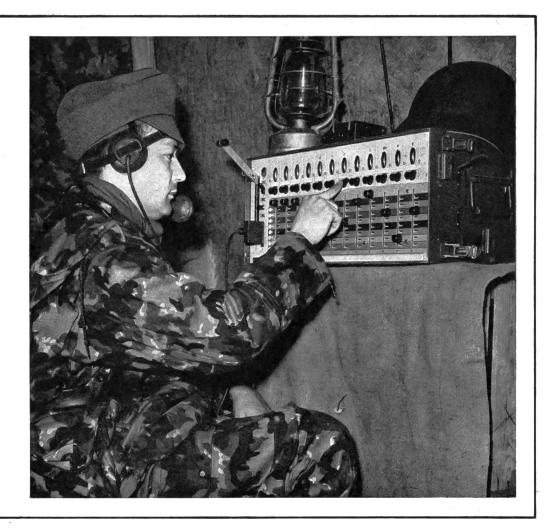
Leistungsfähige Die schnurlose Einheits-Feldtelefonzentrale Drahtverbindungen in der Armee
