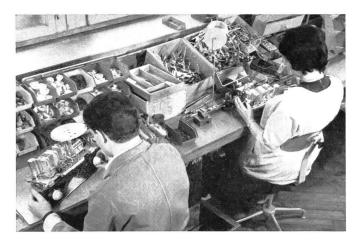
$Fig.\ 2 \\ Montageplätze\ für\ Radioapparate «Biennophone»\ bei\ der\ Firma \\ Velectra\ SA\ in\ Biel$
