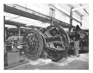
${\rm Fig.~2}$  Verseilmaschine in der Abteilung Draht und Kabel
