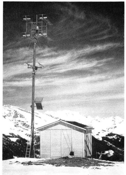
Transistorisierter Fernsehumsetzer Gebidem (Wallis) mit Energieversorgung durch Sonnenzellen
