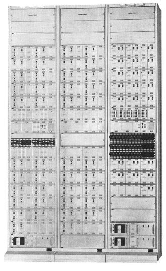
Fig. 19 Sekundärgruppenumsetzerbuchten, enthaltend Sendeumsetzer, Empfangsumsetzer und Regulierverstärker für 21 Sekundärgruppen
