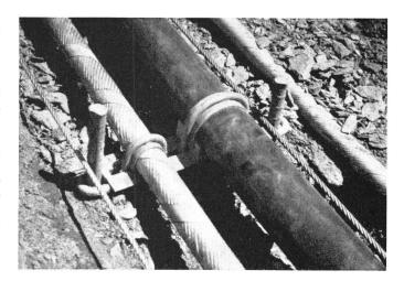
${\rm Fig.~5}$  Sicherung der Kabel und der Abwasserleitung im Steilhang gegen Abrutschen durch Spezialmuffen
