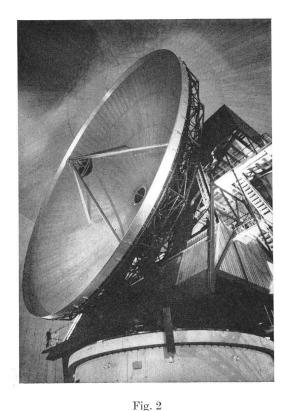
Der nach dem Cassegrin-Prinzip gebaute Parabolspiegel mit dem Fangreflektor und der Austrittsöffnung für die Hornparabolspeisung
