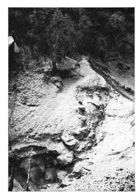
Fig. 2. Erosion à l'emplacement des câbles téléphoniques
