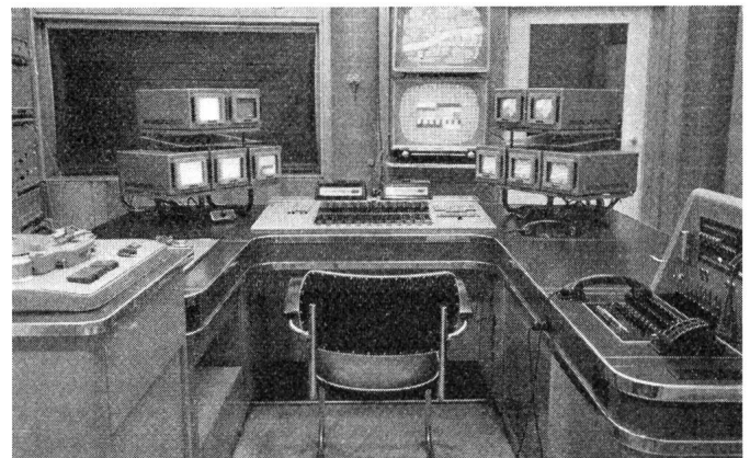
Fig. 3. Bedienungsplatz des Tonsternpunktes
