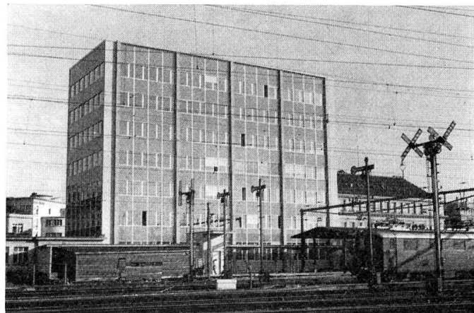
Fig. 1. Das neuerstellte PTT-Hochhaus neben der umgebauten Hauptpost in Biel, vom Bahnhofareal aus gesehen
