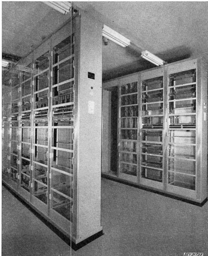
Fig. 9. Vue partielle d'un central crossbar. Au premier plan, des bâts de sélecteurs d'abonnés; à l'arrière-plan, des bâts de sélecteurs de connexion
