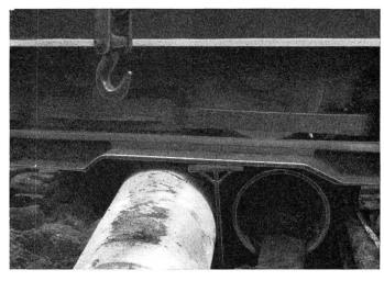
Fig. 4. Konstruktiv geänderte Strassenbahnschienen, da nur so eine Unterführung der kreuzenden Rohre noch möglich war (Bilder OPD Hamburg u. C. Aug. Schmidt Söhne, Hamburg 22)
