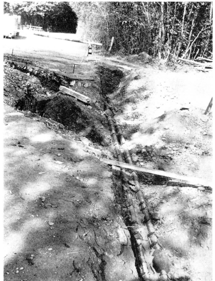
Fig. 4. Die Schadenstelle nach der Behebung der Kabelstörung. Vorne rechts und hinten links die Kabelschutzmunfen
