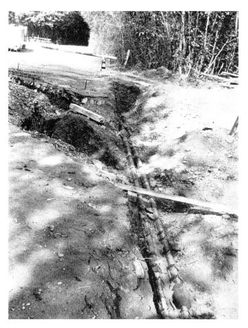
Fig. 4. Die Schadenstelle nach der Behebung der Kabelstörung. Vorne rechts und hinten links die Kabelschutzmuffen
