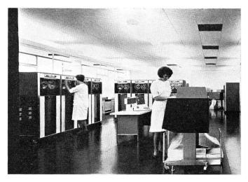
Fig. 5. Die IBM-Anlage 1410 setzt sich u. a. aus acht Bandeinheiten, einem Hochleistungsdrucker (rechts) sowie einem Magnetplattenspeicher (der in Bild 4 im Hintergrund sichtbar ist) zusammen
