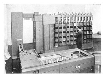
Fig. 16. Weichen-Briefverteilmaschine System Telefunken mit feststehenden Ablagefächern
