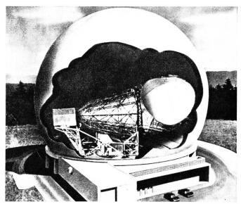
Fig. 11. Maquette d'une station au sol munie d'une antenne en cornet parabolique ayant une ouverture de 335 m² et protégée des intempéries par une enveloppe spéciale (Radom). Le gain de l'antenne est de 60/57 dB pour une fréquence de 6000/4000 MHz
