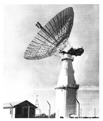
Fig. 10. Antenne parabolique servant aux liaisons avec les satellites, diamètre environ 26 m (Tiré du Rapport technique nº 32–137 de la NASA)
