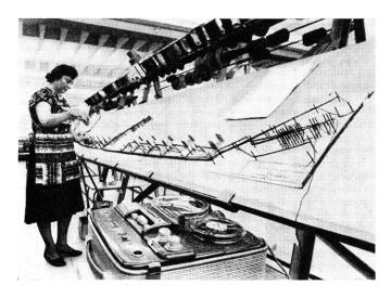
Interessantes Detail aus der Fertigung: Das Legen der für die verschiedenen Geräte benötigten Kabelbäume geschieht nach den gesprochenen Anweisungen, die der Arbeiterin (über Ohrhörer) von einem Tonband erteilt werden
