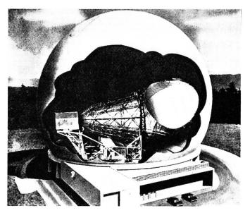
Fig. 11. Modell einer Bodenstation mit Hornparabolantenne von 335 m² Öffnung und Schutzhülle (Radom) gegen Wettereinflüsse. Der Antennengewinn liegt bei 60/57 dB für eine Frequenz von 6000/4000 MHz
