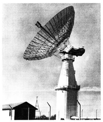
Fig. 10. Parabolantenne für Satellitenverbindungen, Durchmesser etwa 26 m (Aus Technical Report N $^{\rm o}$  32–137 der NASA)
