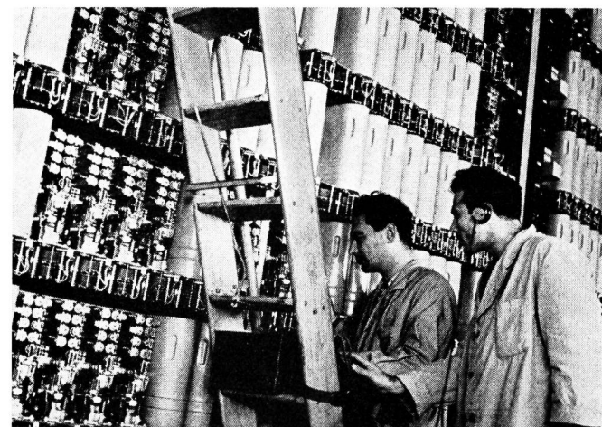
Die grossen, durch General Electric oder Autelco gebauten Stadtzentralen arbeiten alle nach dem Direktwahlprinzip
