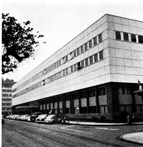
Fig. 1. Gesamtansicht des Genfer Fernsehentrums, dessen linker Flügel von Radio Genf belegt ist
