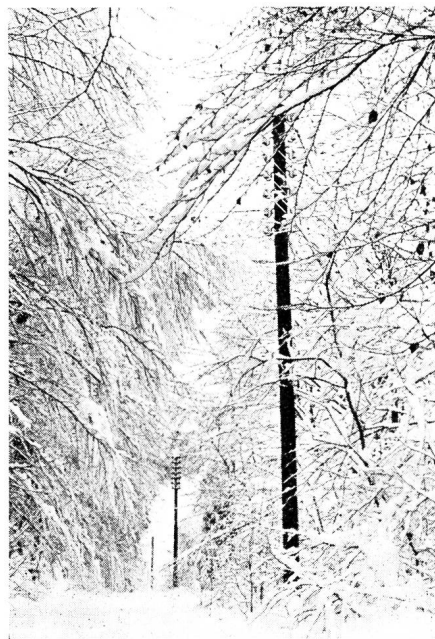
Durch Wald führende Freileitungen wurden häufig von stürzenden Bäumen oder Ästen zerrissen oder es traten, verursacht durch schneebedadene Äste, Kurzschlüsse und Verwicklungen in den Stromkreisen auf
