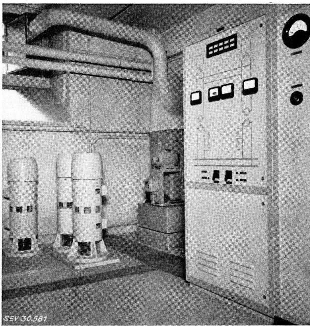
Fig. 13. Energieversorgungsanlage 10 kVA, 220 V, 50 Hz, für Koaxialkabelverstärker. Links die Zweimaschinen-Umformergruppen, rechts das zugehörige Steuer- und Schaltfeld
