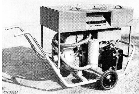
Fig. 18. Tragbare Notstromanlage 3 kW für 60-V-Gleichstrom mit Benzinmotor und abnehmbarem Schaltpult für den Einsatz
