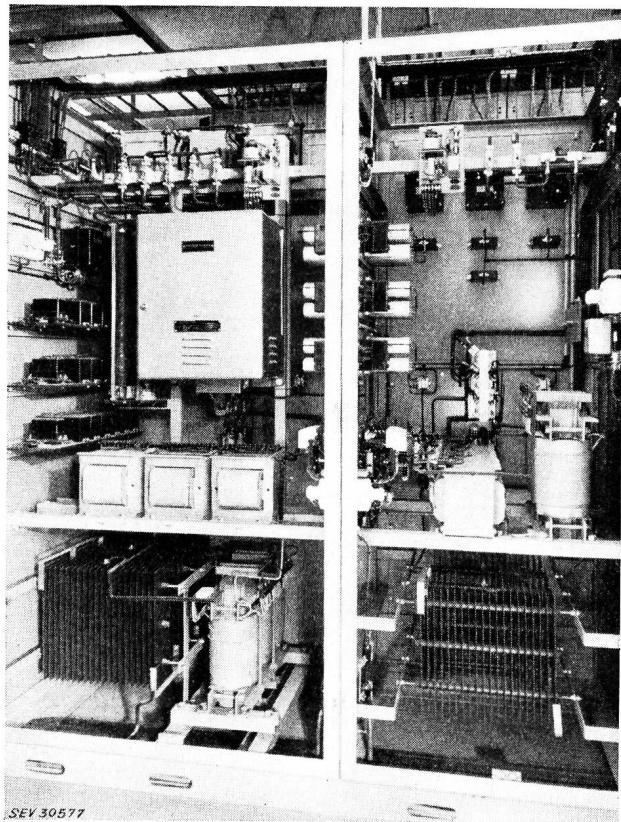
Fig. 9. Aufbau einer Gleichrichteranlage für Anodenspeisung 220 V, 30 A, nach Figur 8. Links befindet sich der 30-A-Hilfsgleichrichter *Gl2* und der Kohledruckregler, rechts ist der 30-A-Grundlastgleichrichter *Gl1* ersichtlich
