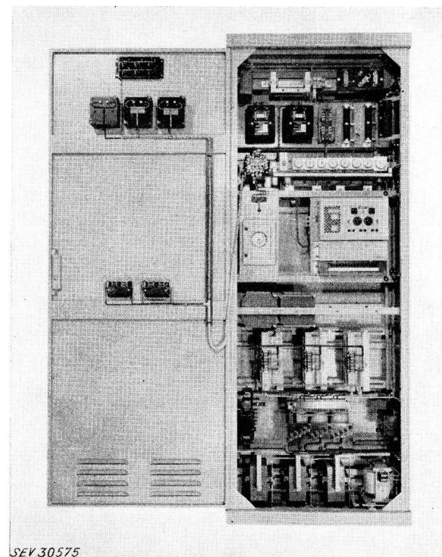
Fig. 7. 48-V-Gleichrichteranlage für einen maximalen Belastungsstrom von 60 A, ausgebaut für 30 A. Von unten nach oben sind unter anderem die Gleichrichterelemente, der Transformator, die Regulierdrosselpulen, die Gegenzellenelemente und der Spannungsregler ersichtlich
