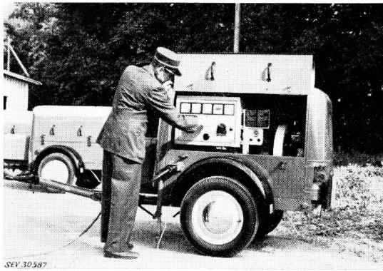
Fig. 19. Fahrbare Notstromanlage auf Einachsanhänger. Leistung 17 kVA, 220/380 V, 50 Hz, mit Antrieb durch Benzinmotor
