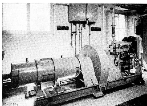
**Fig. 16.** Ansicht einer Energieversorgungsanlage 20 kVA, 3 × 220/380 V, 50 Hz, mit Schwungradspeicher für unterbruchlose Übergang auf Dieselbetrieb bei Netzausfall. Links ist die Umformergruppe (Asynchronmotor/Wechselstromgenerator), in der Mitte das Schwungrad und rechts der Dieselmotor ersichtlich
