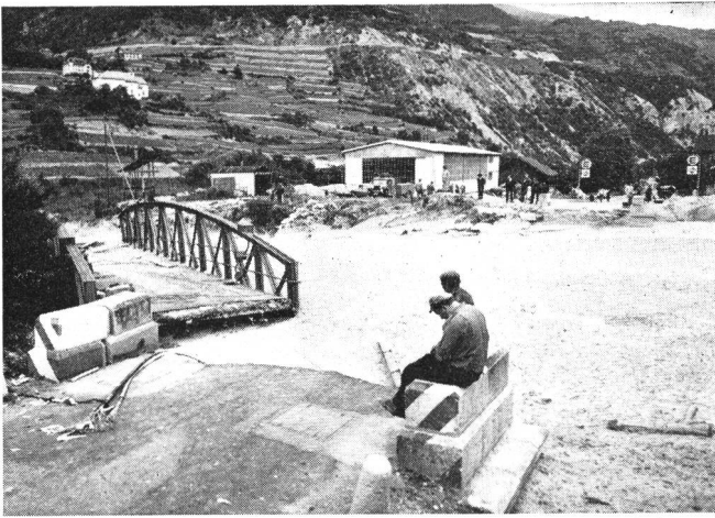
fig. 1. La route du Simplon traversait ici l'Iligraben. Sous la pression de la masse en mouvement, le pont de fer (à gauche) se rompit dans la nuit du 5 au 6 juin et fut transporté plus loin. Au premier plan, deux câbles téléphoniques arrachés
