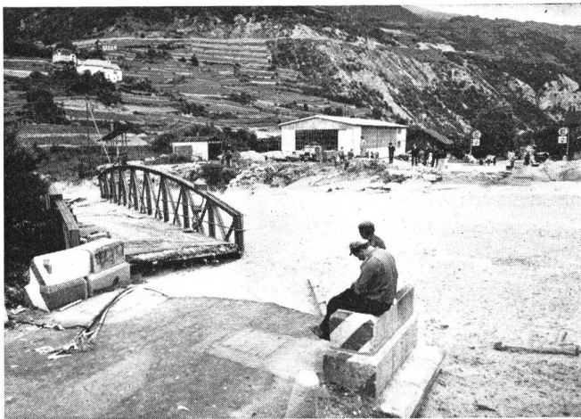
fig. 1. La route du Simplon traversait ici l'Ilgraben. Sous la pression de la masse en mouvement, le pont de fer (à gauche) se rompit dans la nuit du 5 au 6 juin et fut transporté plus loin. Au premier plan, deux câbles téléphoniques arrachés
