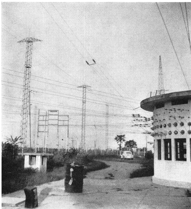
Fig. 8. Centre d'émission radio au beam à Léopoldville, à droite l'entrée d'antennes au beam
