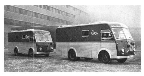
Fig. 1. Der neue Fernseh-Übertragungszug für die Südschweiz. Die Anlage ist auf zwei Fahrzeuge aufgeteilt, den Technikwagen (links) und den Regiewagen (rechts)
