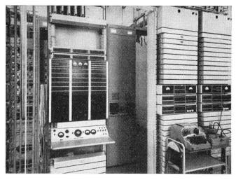
Fig. 16. Distributore, terminazioni e commutatori di linea
