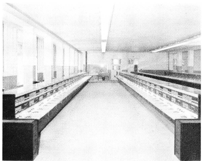
Fig. 1. Das zur Bewältigung des Telephonverkehrs der XVII. Olympischen Spiele eigens errichtete Fernamt mit seinen rund 100 Plätzen.
