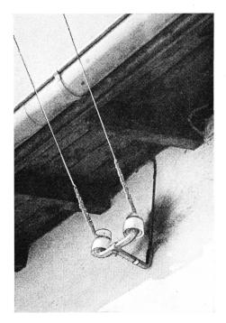
Fig. 11. Brandspuren an der Telephonzuführung, von Blitzschlag herrührend. Die Isolatoren waren damals nirgends mehr zu finden Tracee d'incendio sull' introduzione della linea telefonica. Causate dal fulmine. Non fu possibile ritrovare gli isola-
