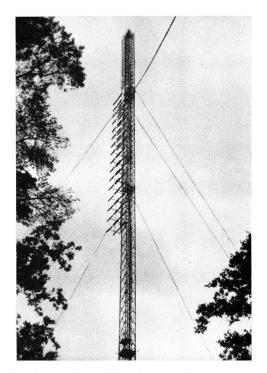
Fig. 7b. Die Spitze des alleinstehenden Funkturmes trägt, in 30 Feldern angeordnet, die 240 Dipole der Fernsehbrücke Berlin-Bundesrepublik
