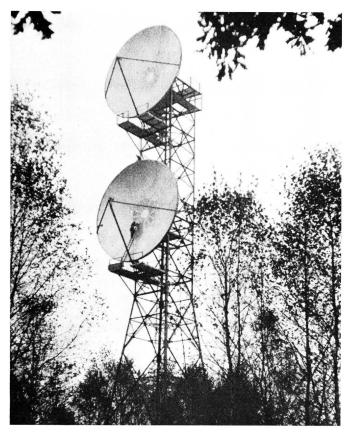
Fig. 10. Antennenanlage der Überreichweiten-Richtfunkanlage auf dem Schäferberg im Südosten Berlins. Die beiden Parabolspiegel haben je zehn Meter Durchmesser, die drei Streben tragen den Strahler im Brennpunkt des Spiegels
