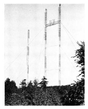
Fig. 7a. Über die Wälder der Havelgegend erblickt man schon weithin die drei 150 m hohen Funktürme von Nikolassee, welche die für die Richtstrahl-Telephonie und die Funkbrücken für Radio und Fernsehen nötigen Sende- und Empfangsantennen tragen
