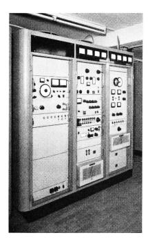
Fig. 5. Sendegestell für 60-Kanal-Trägerfrequenz-Richtfunk Berlin-Höhbeck im VHF-Bereich 235...300 MHz
