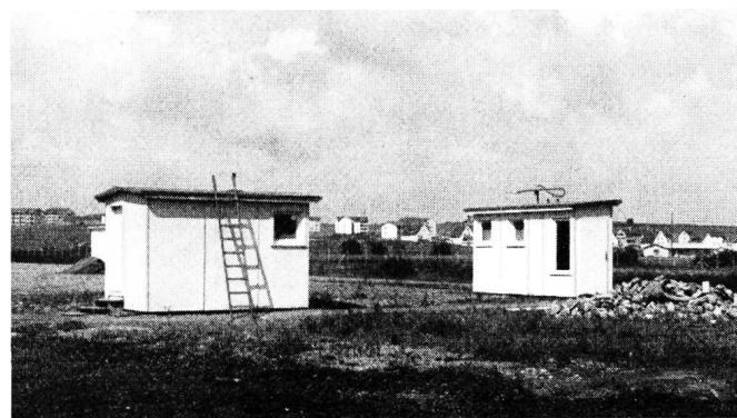
Fig. 5. Um den sehr strengen Anforderungen der Deutschen Post über die zulässigen Störstrahlungen von Rundfunk- und Fernsehgeräten genügen zu können, ist eine laufende Überwachung der Fabrikation auch in dieser Hinsicht nötig. Zu diesem Zwecke ist dieser Messplatz gebaut worden. Während im einen Häuschen der zu prüfende Empfänger auf einem drehbaren Tisch aufgestellt wird, befindet sich in dem zweiten, 10 m entfernten Bau der eigentliche Messplatz, zur Feststellung der ausgestrahlten Störfeldstärke in den verschiedenen Bereichen
