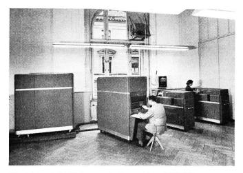
Die elektronische Datenverarbeitungsanlage IBM 650
