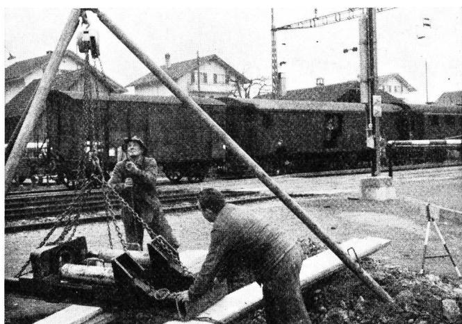
Röhren-Stosswinde für 3- bis 6-Zoll-Stahlrohre an einem Dreibein aufgehängt
