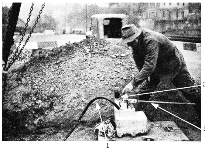
Oeldruckpumpe Pompe foulante à l'huile 1 = Hochdruckschlauch – Tube haute pression 2 = Handhebel – Levier de manœuvre 3 = Manometer – Manomètre
