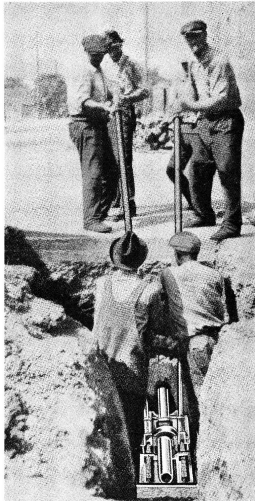
Röhren-Stosswinde eingesetzt. Betätigung von der Grabensohle und vom Grabenrand aus
