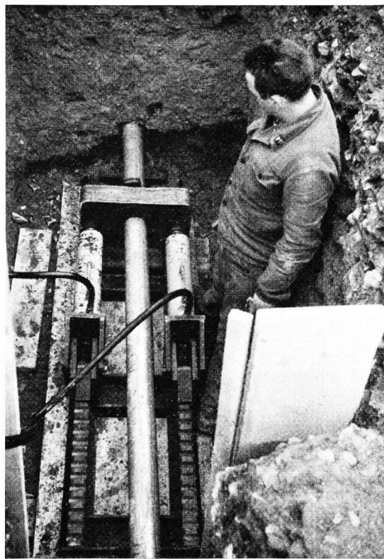
Röhren-Stosswinde für 3- bis 6-Zoll-Rohre in Aktion Pousse-tubes pour tuyaux de 3 à 6" en action
