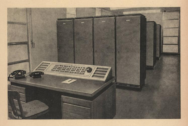
Für die neue Funkanlage der Stadtpolizei Zürich erstellten wir die Ausrüstung für die automatische und manuelle Vermittlung der Funkge-
