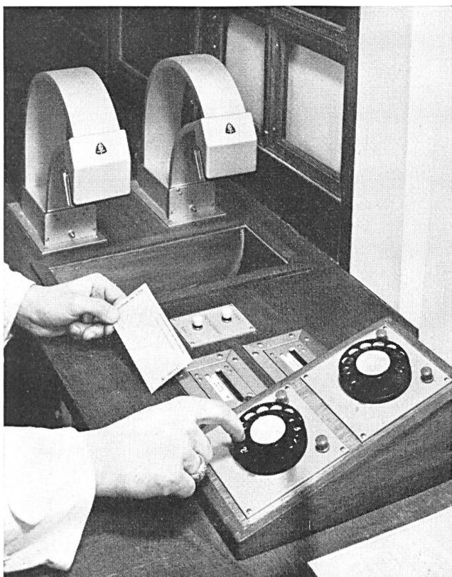
Fig. 11. Zettel-Rohrpost in der Bibliothek der ETH in Zürich. Anordnung der Druckluftsieder mit den zugehörigen Wähl scheiben sowie den Saugluftempfängern
