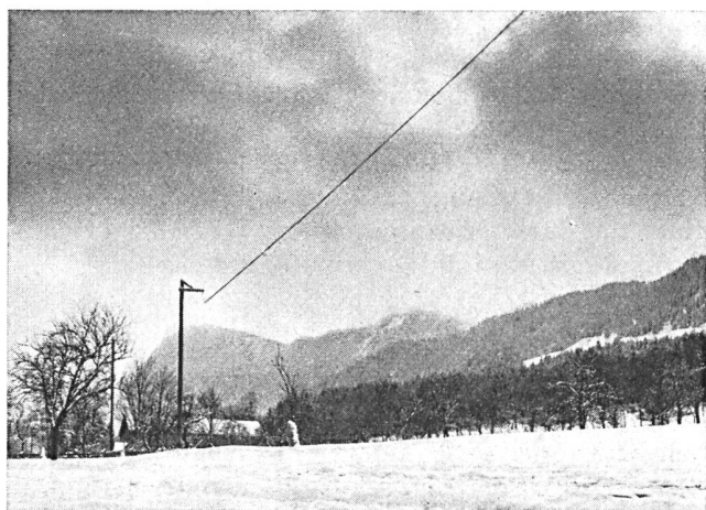
Fig. 6. Praktisch ausgeführte G-Leitungsstrecke als Fernsehzubringer, mit senkrechter Aufhängevorrichtung mittels Nylonschnur an Holzmasten (Photo Kathrein, Rosenheim)
