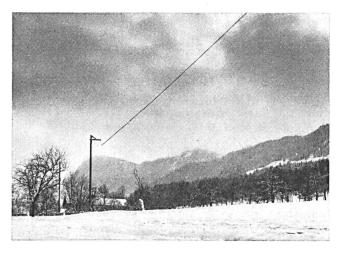
Fig. 6. Praktisch ausgeführte G-Leitungsstrecke als Fernsehzubringer, mit senkrechter Aufhängevorrichtung mittels Nylonschnur an Holzmasten (Photo Kathrein, Rosenheim)
