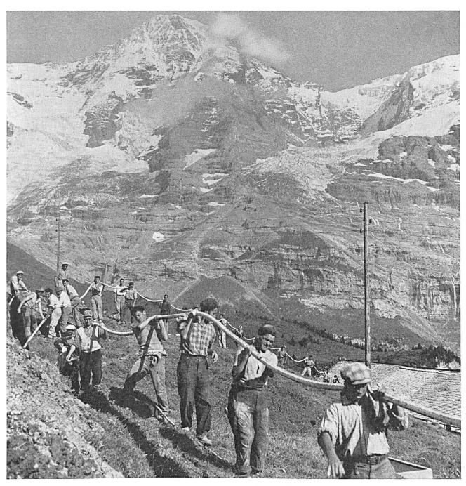
Fig. 3. Das in einem Graben verlegte, der Unbill der Witterung entzogene Kabel ist nicht nur viel betriebssicherer, sondern auch bedeutend billiger im Unterhalt als die Freileitung. Im gebirgigen Gelände ist die Auslegung eines Kabels jedoch oft mit zahlreichen Schwierigkeiten verbunden, und viel harte Arbeit muss geleistet werden, bis die Telephongespräche über die unterirdisch verlegten Leitungen geführt werden können
