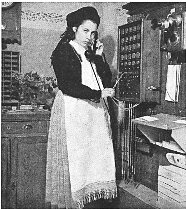
Fig. 8. Aus der guten alten Zeit: Lokalbatterie-Vermittlungszentrale mit Fallklappen für 20 Anschlüsse in Brione (Verzasca)
