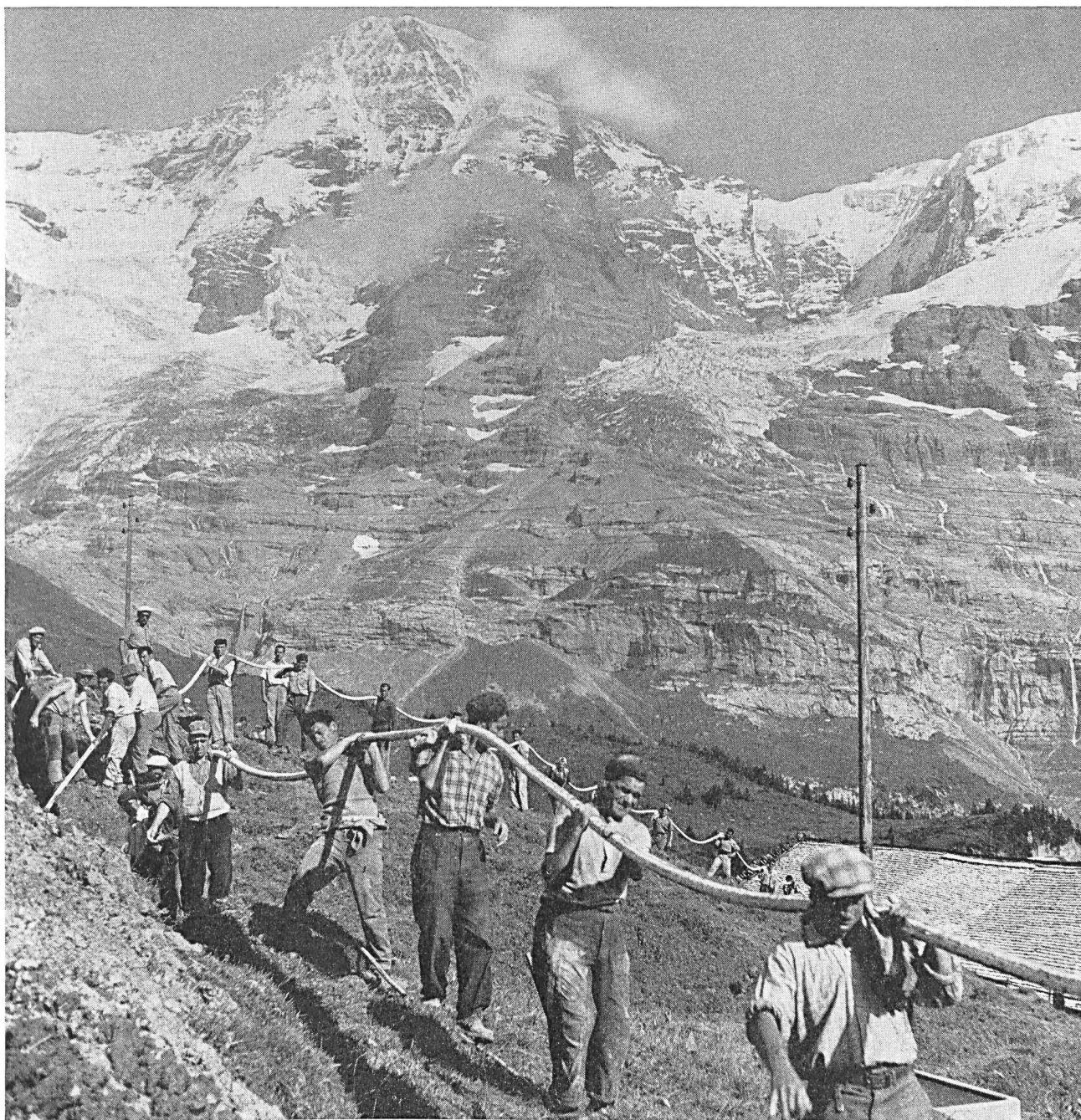
Fig. 3. Das in einem Graben verlegte, der Unbill der Witterung entzogene Kabel ist nicht nur viel betriebssicherer, sondern auch bedeutend billiger im Unterhalt als die Freileitung. Im gebirgigen Gelände ist die Auslegung eines Kabels jedoch oft mit zahlreichen Schwierigkeiten verbunden, und viel harte Arbeit muss geleistet werden, bis die Telefongespräche über die unterirdisch verlegten Leitungen geführt werden können
