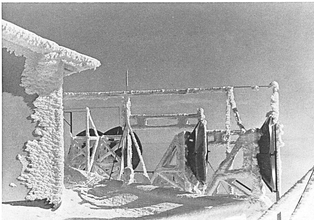
Fig. 4. Neben den Kabelanlagen werden immer mehr auch Richtstrahlverbindungen errichtet. Durch mächtige Parabolspiegel von 3 bis 5 m Durchmesser oder andere Richtantennen werden die elektromagnetischen Wellen im Gebiete der dm- und cm-Wellen gebündelt und auf die bis 100 km entfernt liegende Empfangsantenne, die sich in optischer Sicht zur Sendeantenne befinden muss, gerichtet. Moderne Richtstrahlanlagen können Hunderte von Telefongesprächen gleichzeitig übertragen. Parabolantennen der Richtstrahlrelaisanlage auf dem Chasseral
