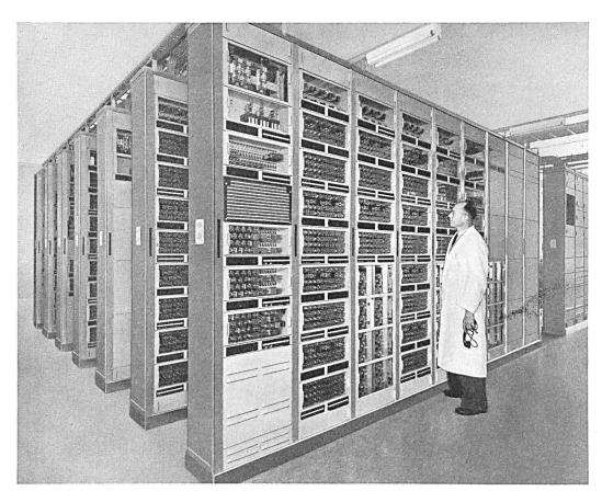
Fig. 10. Durch das Wunderwerk der automatischen Telephonzentrale mit ihren durch elektrische «Gehirne» gesteuerten Wählern und Suchern wird heute praktisch der gesamte inländische Telephonverkehr der Schweiz vollautomatisch wickelt und taxiert. Automatische Zentrale Interlaken mit rund 3000 Telephonteilnehmern. Ausser dem Ortsverkehr vermittelt sie auch den Bezirks- und Fernverkehr der Netzgruppe Interlaken für rund 7000 Teilnehmer
