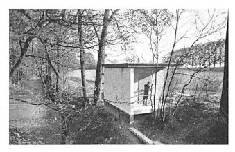
Fig. 5. Station de répéteurs intermédiaire pour câble coaxial
