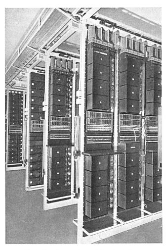
Fig. 8. Vue d'une ancienne station de répéteurs
