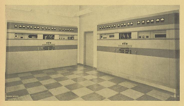
Sendersaal der Anlage Klagenfurt-See mit den beiden Brown Boveri Mittelwellensendern von je 25 kW Trägerleistung
