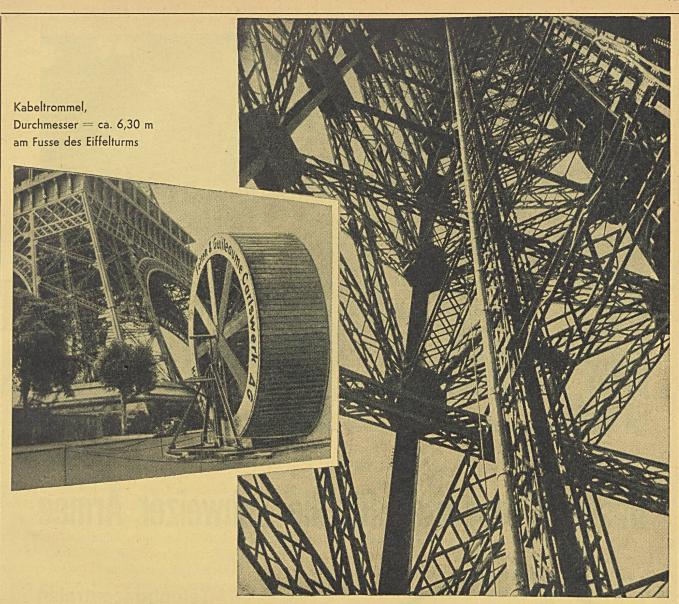
Verlegtes F & G-Hochfrequenz-Sendekabel, 61/8", für den Fernseh-Großsender Eiffelturm, Paris
