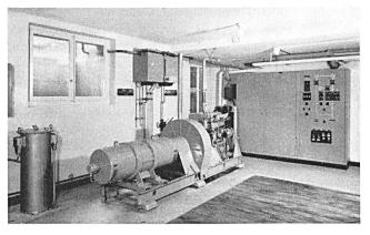
Fig. 3. Anlage für unterbruchslose Wechselstromspeisung (220 V  $\pm$  1%, 24 kVA) mit Asynchronmotor und -generator, Schwungrad, Dieselmotor und Regulierung
