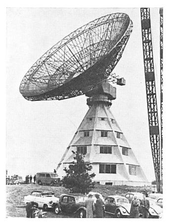
Fig. 17. Radioteleskop der Universität Bonn mit einem 25-m-Spiegel
