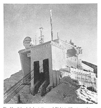
Fig. 15. Schwebebahnstation und Richtstrahlknotenpunkt Säntis Parabolspiegel und Winkelreflektoren für 2000 MHz Der hohe Mast ist die Autorufantenne
