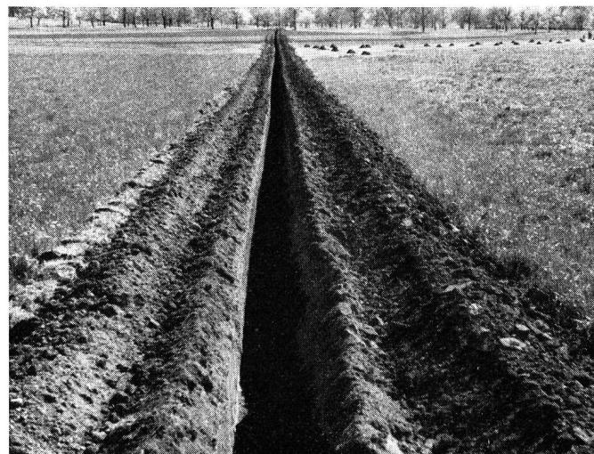
Fig. 10. Beispiel eines mit Kettenbagger ausgehobenen Grabens.
