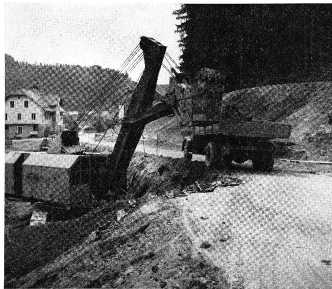
Fig. 1. Hochlöffelbagger beim Abtragen von standfestem Boden im Strassenbau
